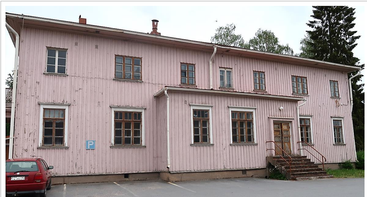
Julkisivu etelästä (kuvausaika 06/2021).
