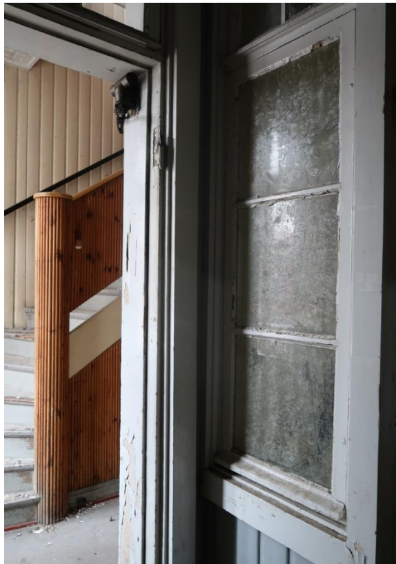
Porrashuone ja eteinen (kuvausaika 06/2021).
