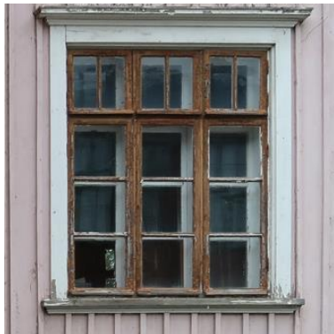
1. kerroksen ikkunoita (kuvausaika 06/2021).
