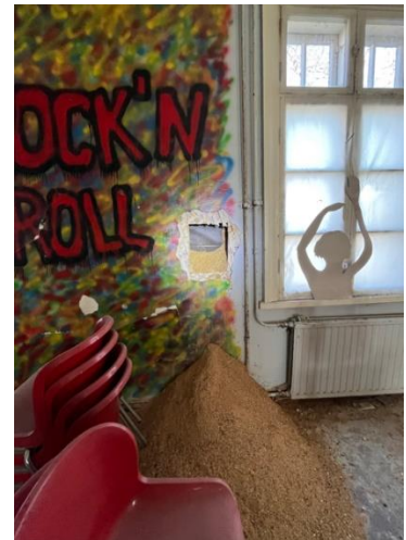
Näytteenottoaikka pohjoisseinällä (kuvausaika 05/2023 Heidi Hulkki).
