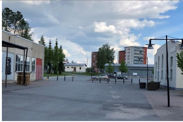
Tilikonttori on Paruunatehtaan rakennusryhmän reunalla (Kuvausaika 06/2021).
