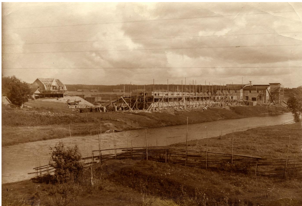
Kuva 3. Sähkövoiman paperitehtaan rakentumista vuosina 2019-2020. (Patruunatehtaan museo).
