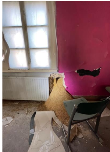
Näytteenottoaikka pohjoisseinällä (kuvausaika 05/2023 Heidi Hulkki).
