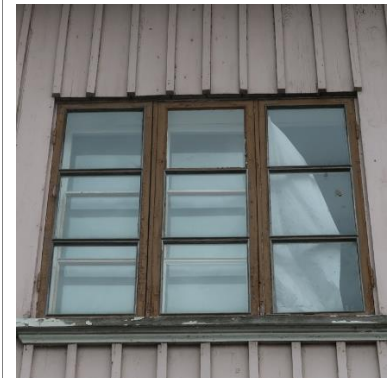
2. kerroksen ikkuna (kuvausaika 06/2021).
