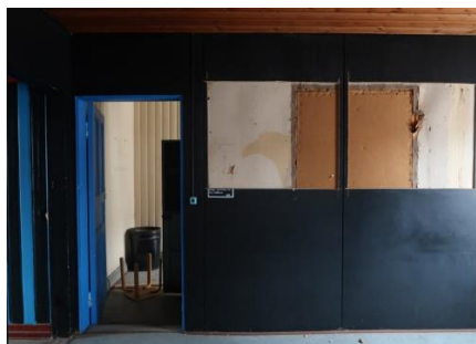
Näkymä porrashuoneen suuntaan (kuvausaika 06/2021).
