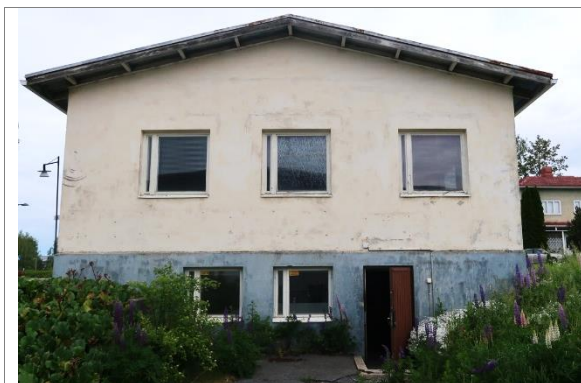
Julkisivu etelään. (kuvausaika 06/2021).
