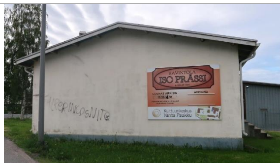
Julkisivu pohjoiseen. (kuvausaika 06/2021).
