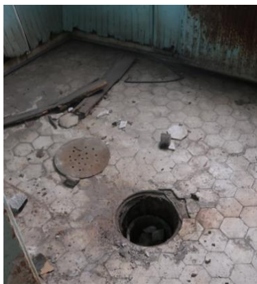
Keittiön viereisen pesuhuoneen lattia (kuvausaika 06/2021).
