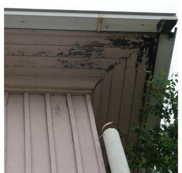
Räystään yksityiskohta (kuvausaika 06/2021).
