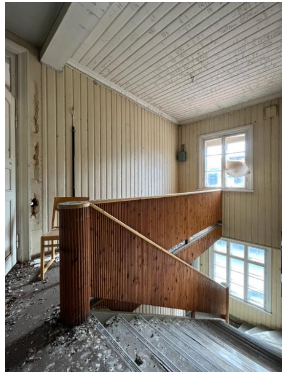
Porrashuone ylätasanteelta (kuvausaika 05/2023 Heidi Hulkki)
