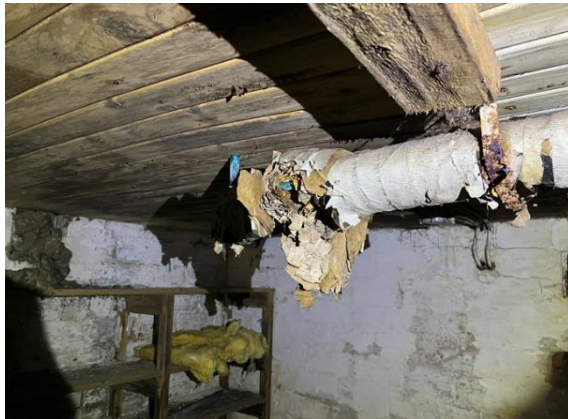
Kattorakenteita (kuvausaika 05/2023 Heidi Hulkki).
