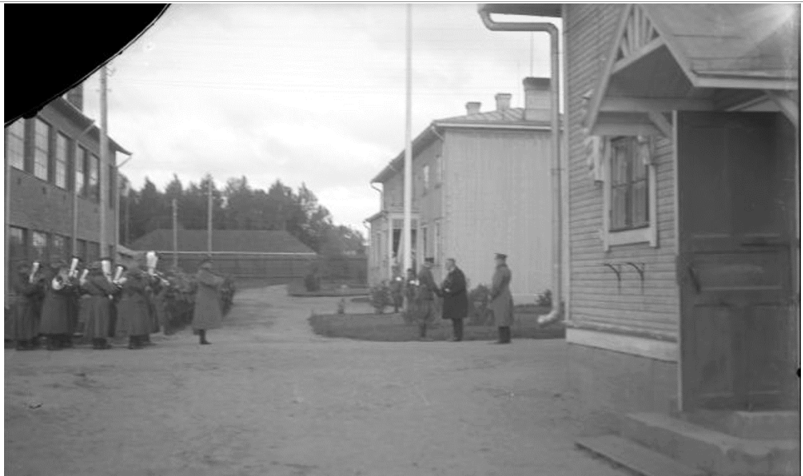
Ruokala idän suunnasta 1900-luvun alkupuolella. Vasemmalla työkalutehdas. Etualalla oikealla on 1920-luvulla rakennettu tehtaanjohtajan asuinrakennus. Taustalla lääkäri­län piharakennus. (Kuva, Lapuan kaupungin museo)
