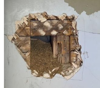
Näytteenottoaikka pohjoisseinällä (kuvausaika 05/2023 Heidi Hulkki).
