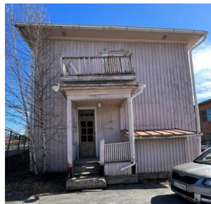
Pääty länteen (kuvausaika 05/2023).
